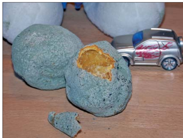
Schimmel im Kinderzimmer.
